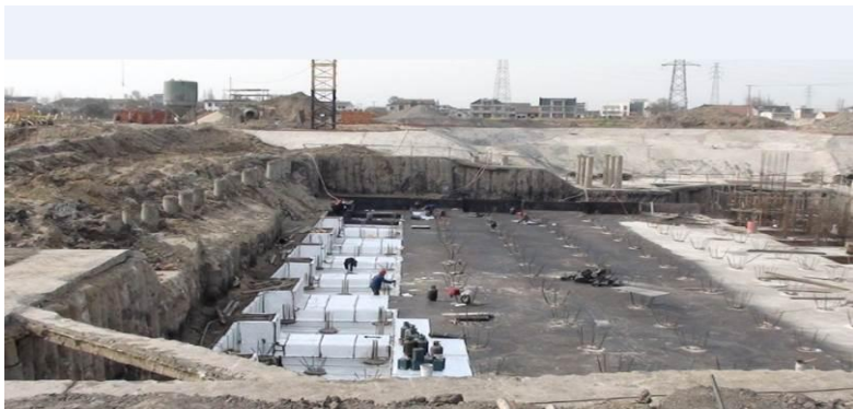
垃圾坑底部防渗施工
