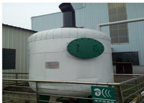
锅炉定排水池
