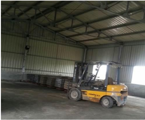
飞灰固化制砖后临时堆场
