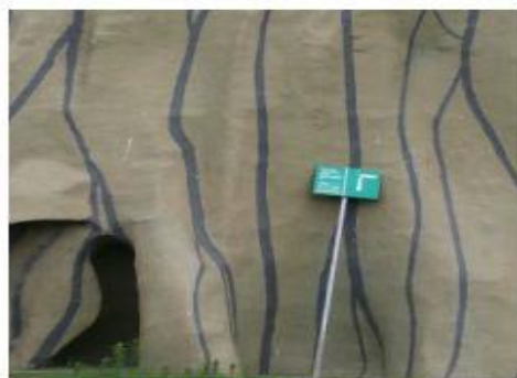
废气排口标志牌
